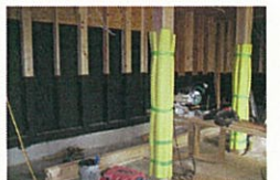
床下に 『ヘルスコ・キューア』 防蟻・防腐処理
